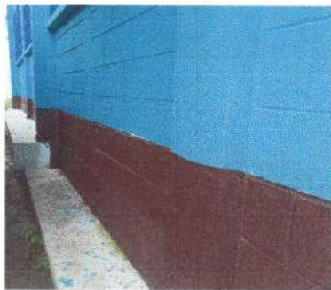
Foto 3: En esta fotografía se observa que con la pintura ha quedado mejor, puestoque con la lluvia se había deteriorado, ahora vemos una vista diferente.
